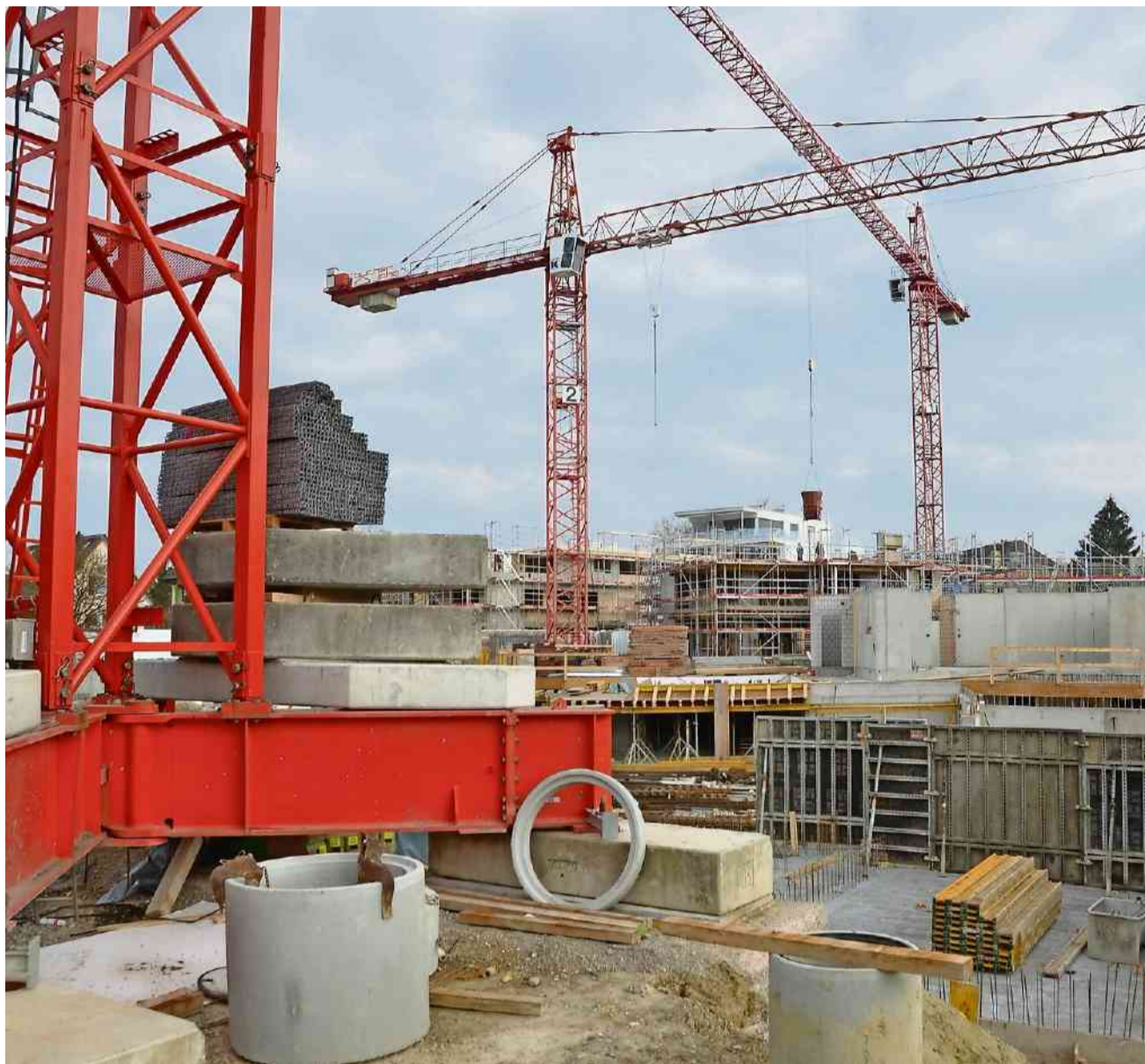
Wohlen entwickelt sich als Regionalzentrum und Wohnort weiter: Baustelle des Wohnparks Steindler.
